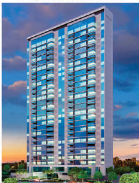
Maison Lumini Parque do Ingá (Maringá), finalização em abril.
